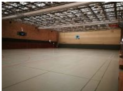
Dreifachhalle im Sportpark Nord
